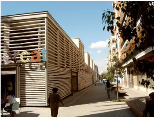
Detalles de la fachada principal
